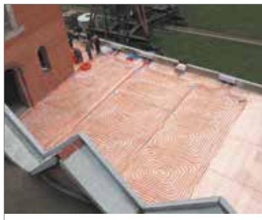
Подпольное отопление, выполненное мокрым методом - греющие трубы замоноличены в полу
