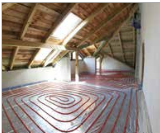
Подпольное отопление, выполненное мокрым методом - греющие трубы замоноличены в полу
